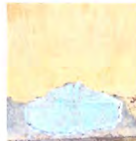
Foto 6: REPARACIÓN DE REPELLO Y CERNIDO DE PAREDES Reparación de repello y cernido en muro de mampostería con aplicación de acabado uniforme. Aula, baños
