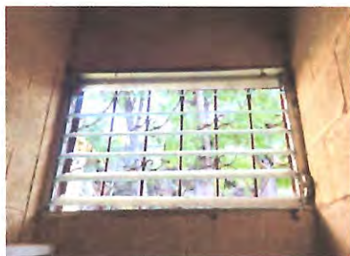
Foto 5: VENTANAS Sustitución de ventanas; sistema de apertura: Corredizas, Perfiles color blanco estandar, Material del marco: PVC Material de la ventana: Vidrio, sellado perimetral. Baños
