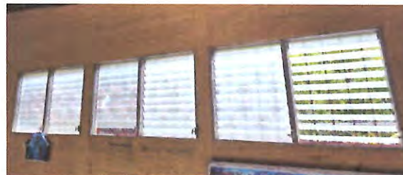
Foto 2: VENTANAS Sustitución de ventanas; sistema de apertura: Corredizas, Perfiles color blanco estandar, Material del marco: PVC Material de la ventana: Vidrio, sellado perimetral. Aula
