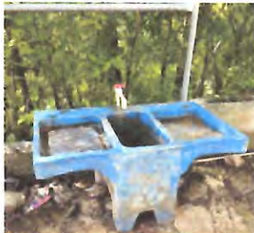
Foto 1: REPARACIÓN O SUSTITUCIÓN DE ÁREA DE COCINA sustitución pila, nivelada y con conexiones hidráulicas.
